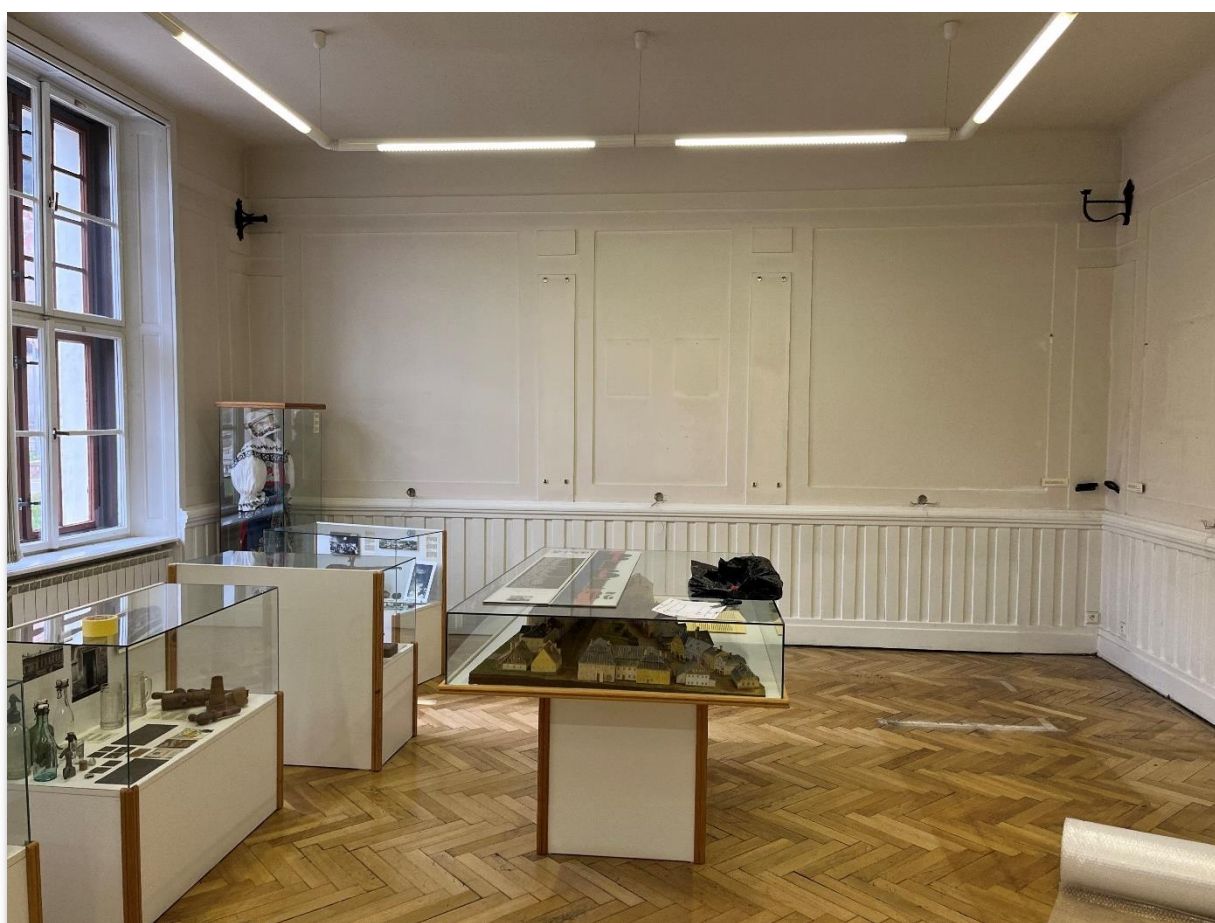
Příprava na výmalbu a instalaci nového zabezpečovacího zařízení v první místnosti stálé expozice a stěhování mobiliáře, listopad 2022
